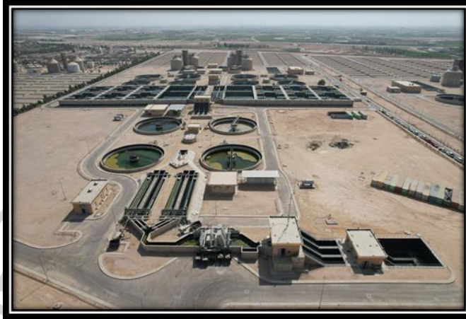
الصورة (٢) محطة معالجة الصرف الصحي في كربلاء
